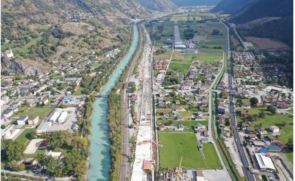
Raron im Oktober 2021 mit der markanten Autobahnbaustelle
